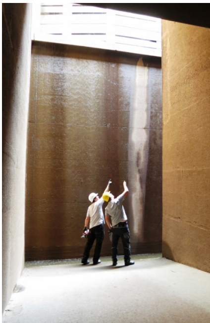
Inspektion reparaturbedürftiger Stellen, Schleuse Gelsenkirchen, Rhein-Herne-Kanal.
