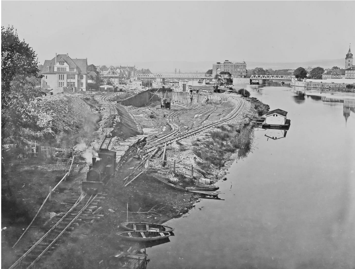
Bau der Schleppzugschleuse Hameln/Weser (Aufnahmejahr: 1929)
