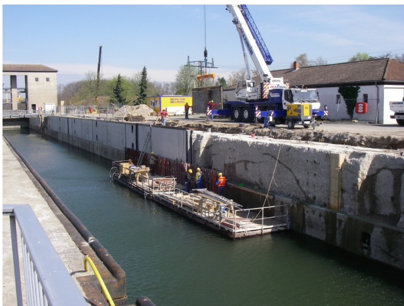
Reprofilierung der Schleuse Wedtlenstedt mit Fertigteilen (2011)
